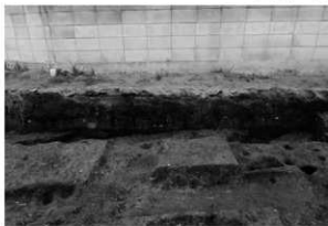
畝状遺構土層断面 (南から)
