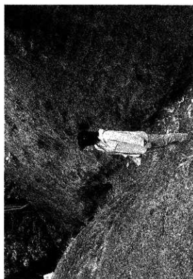
図版10 堀切の整備状況 埋土や崖底は吹き付けられている
