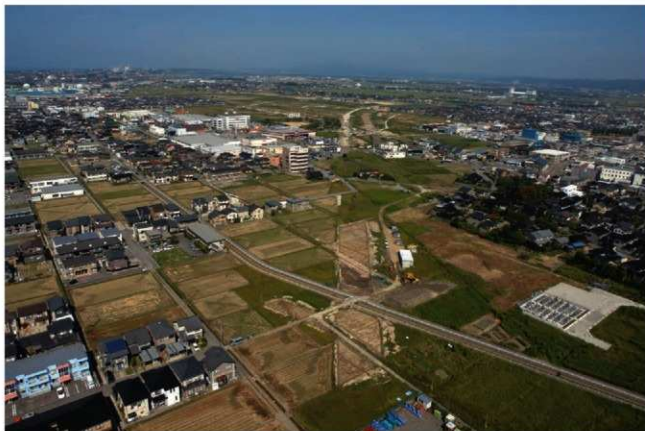
遠景(北東方向を望む)
