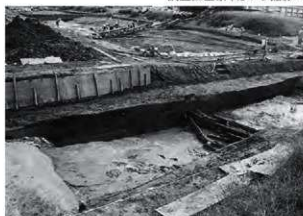
大河跡土層断面(北東から)
