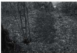
埋め戻し状況（南から）
