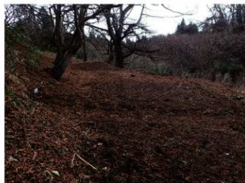
埋め戻し状況 (西から)
