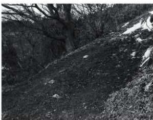
埋め戻し状況 (北から)
