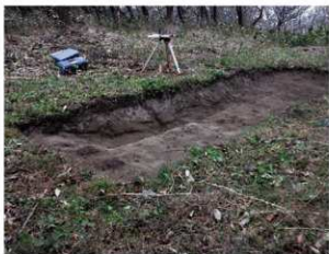
トレンチ掘削状況 (北東から)
