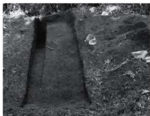
トレンチ掘削状況 (南から)
