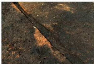
2 F-1断面 (北東から)
