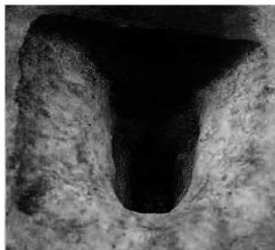
TP-2 土層断面 (北から)
