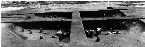
H-6 南北土層断面(西から)
