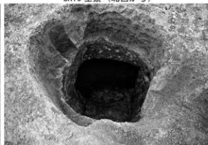
SK16 竖坑部分全景 (北西から)
