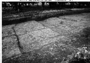
SD01～03 全景 (南東から)
