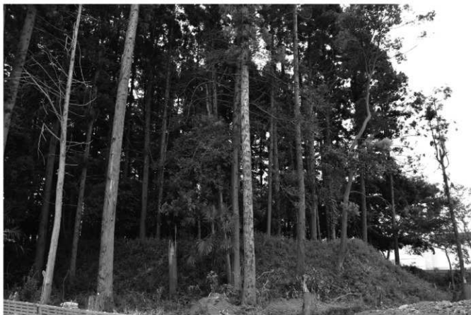
掩体壕全景（南より）
