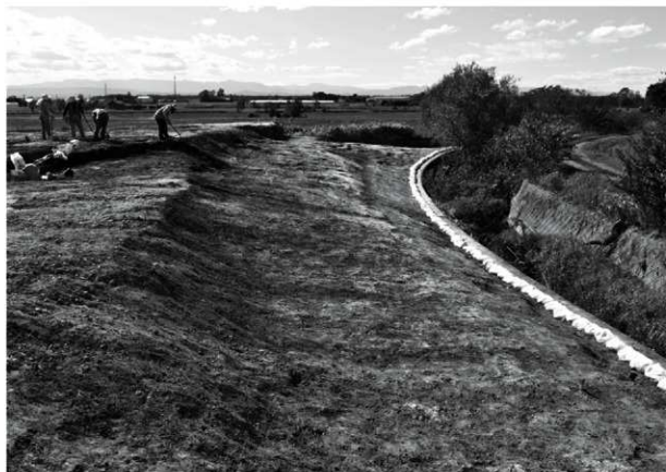
2 富士戸川護岸部分
