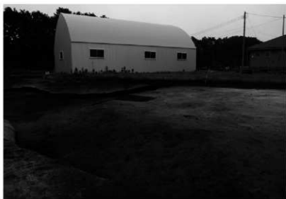
3 完掘（北西から）
