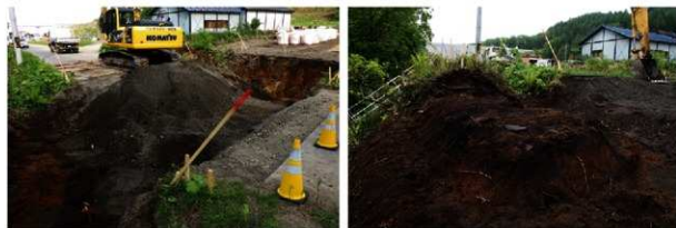
1. 立会地区工事状況
