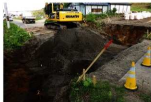
1. 立会地区工事状況
