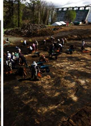
5. III層調査状況
