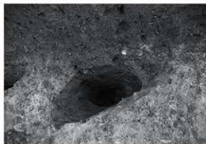
SK113断面 NE→
