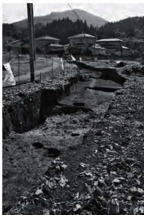
D区 (平成28年10月)
