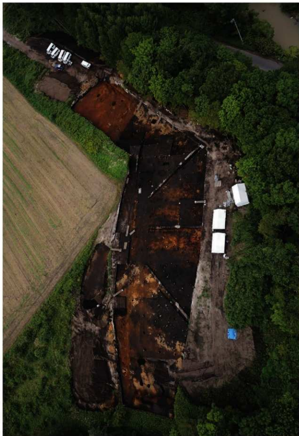
調査区の状況（マルチコプター撮影）
