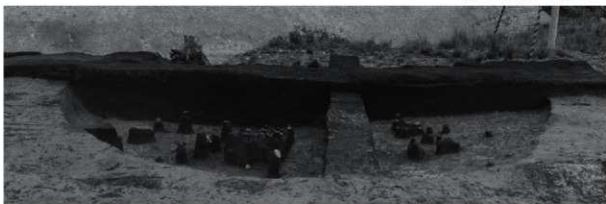
H-11 東西土層断面 (南西から)
