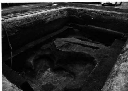
SK01・SD05完掘状況 （北東より）
