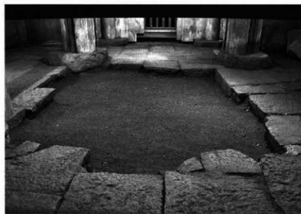
埋戻し後の防空壕（北より）
