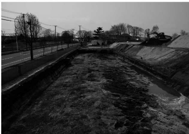
2 表土除去後（平成30年度）
