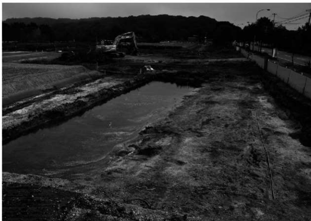
1 表土除去後（平成29年度）
