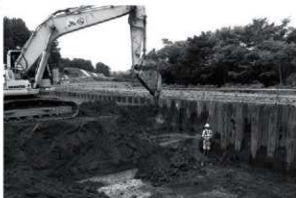
2 耕作土及び盛土の除去作業状況
