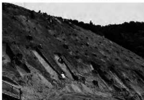
3区作業風景(南から)
