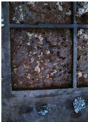
図版77. H12グリッド劣態状況
