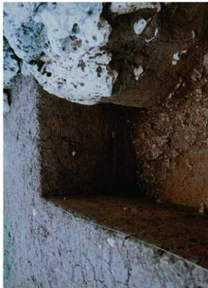
図版65. 12グリッド石積み内側西セクション（南東側より）
