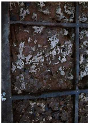
図版73. H11グリッド完張状況
