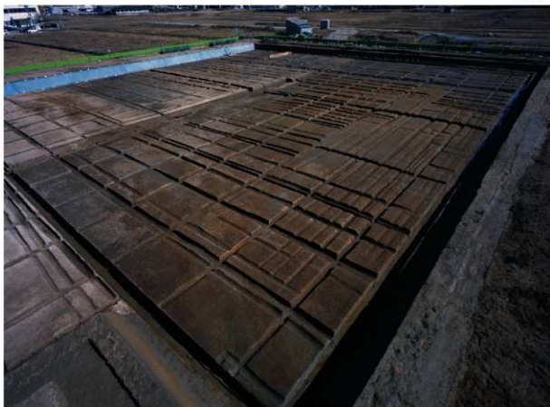
1区 上層遺構完掘状況、下層遺構検出状況（南西から）
