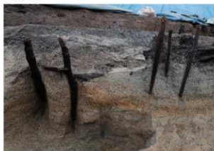
2区 河道 杭列①南半竪杭出土状況（東南東から）
