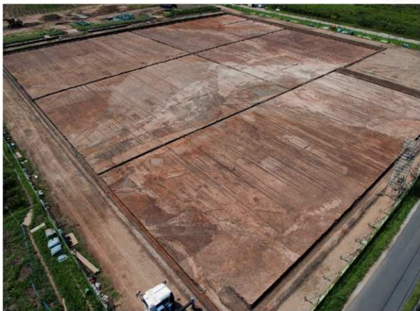
2区 上層道構完掘状況、中層道構検出状況（北東から）
