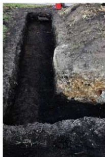
追加トレンチ1（南から）
