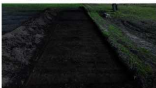
6AIB-D区東西トレンチ全景② (西から)
