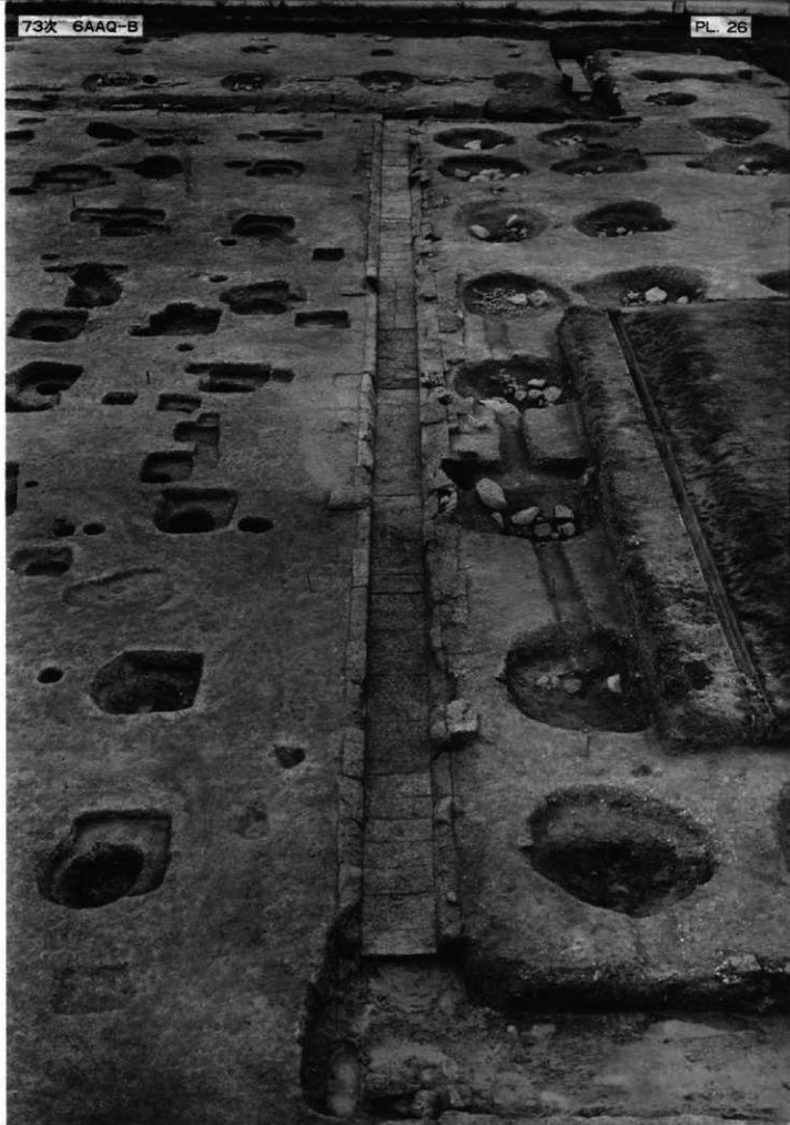
SB7601・SB7600北側雨落溝・SX7602・7603 西から
