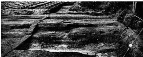
2. 北面大垣SA2300 瓦敷き施設SX2333 南から
