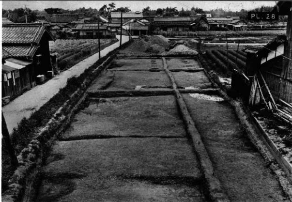
1. J地区全景 南から
