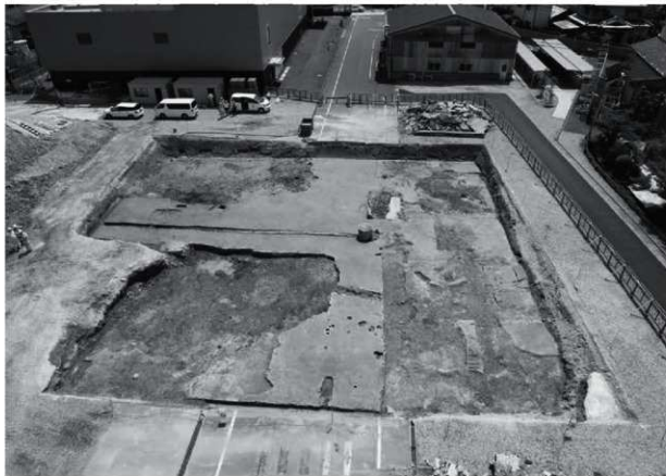
2. 第2面全景（西から）
