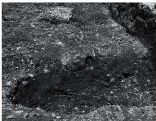
図57 延石掘え付け状況(南から)
