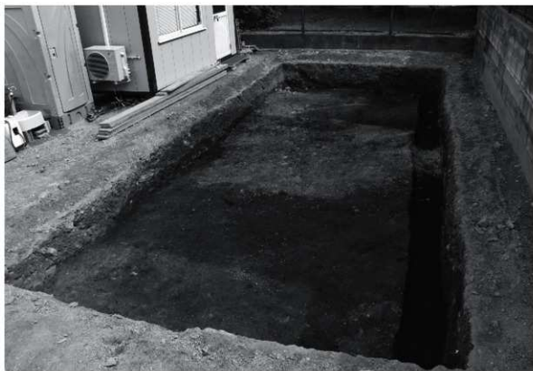
3 第8次調査 第1面全景(南から)
