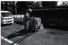
図2 アスファルトカット風景（南西から）
