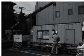
図3 機材搬入風景（北東から）
