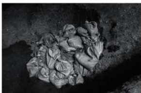
図10 9区石積養生状況（南から）
