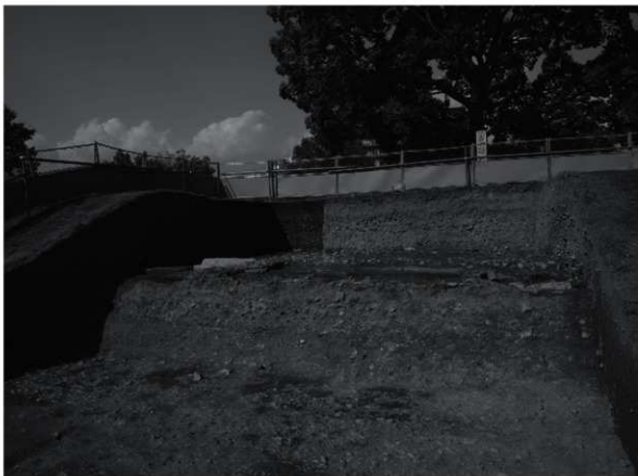
1 4区講堂基壇（南東から）
