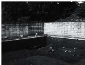
図3 調査地と土塁の関係（南東から）
