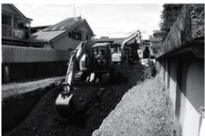
図5 埋め戻し風景（南東から）
