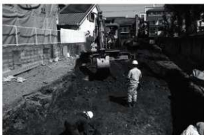
図4 重機掘削風景（南から）
