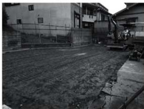
図6 埋め戻し風景（南西から）
