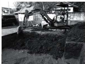
図5 埋め戻し風景（北東から）
