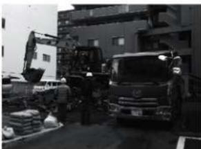
写真2 アスファルトの産廃処分場搬出
