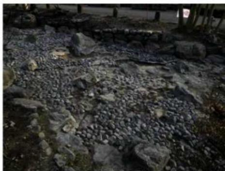
写真1 円山公園の流路底の石が欠損している状況（提供：植彌加藤造園株式会社）
