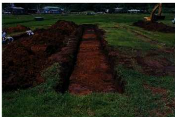
家浦遺跡 トレンチ2 (南東から)
