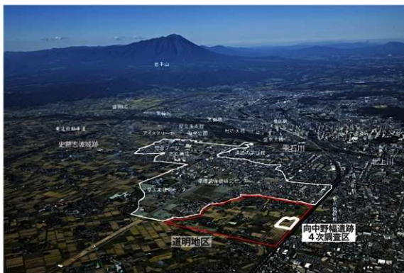
盛岡南新都市区画整理事業区域（白線）・道明地区区画整理事業区域（变更前・赤線）（南東から）
