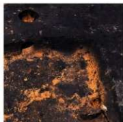
カマドb煙道・煙出し
