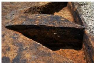
床構築土層断面
