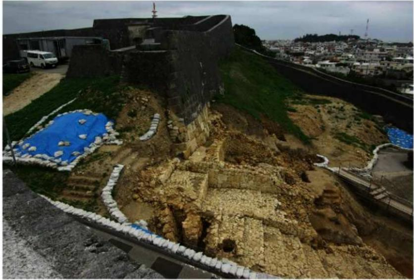
7-2 美福門基礎及び階段（石列2、階段1）・土留め石積み（石積み9）と復元城壁 崇西より
