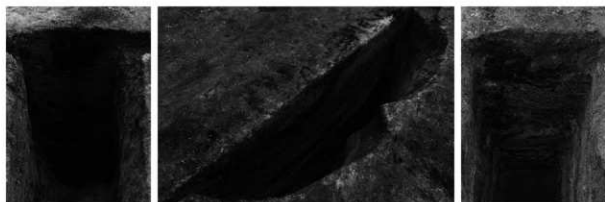
TP-347土層断面(北東から) TP-348(左)・TP-349(右)土層断面(南西から) TP-352土層断面(東から)
