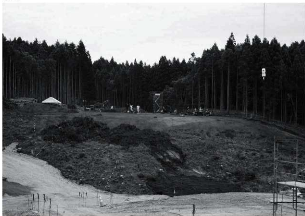
調査状況 NW→SE
