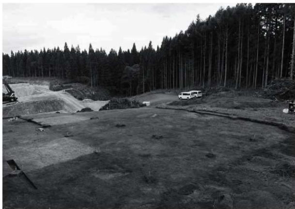
調査終了状況（Eライン以北）SE→NW
