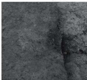
F - 3 検出状況 NW → SE
