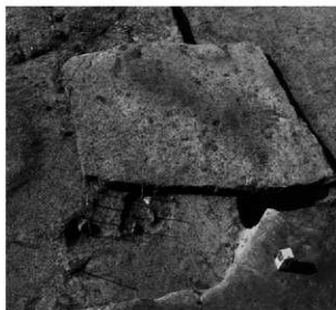
5 S-1 の検出 (南西から)
