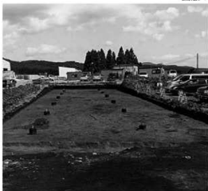
完掘 (補償道路部分)
