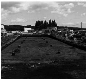
完掘 (補償道路部分)
