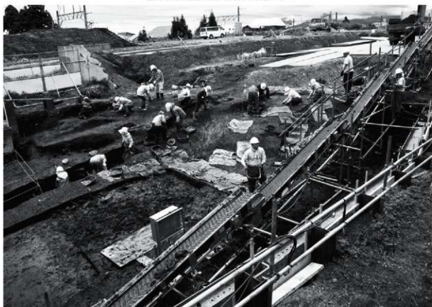
斜面調査状況（北→）
