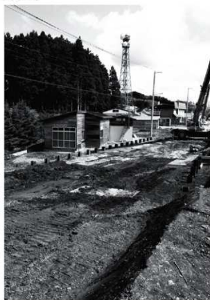
H鋼打設作業終了状況（南→）
