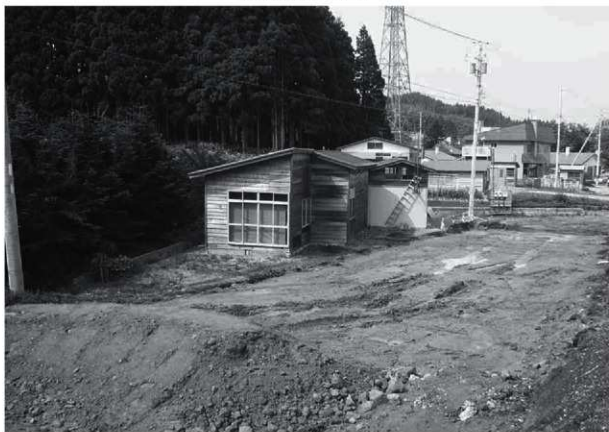
矢板撤去後埋戻し状況（南→）
