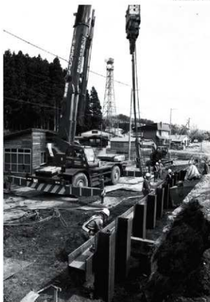
H鋼打設作業状況（南→）
