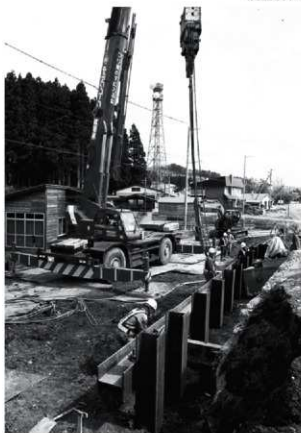
H鋼打設作業状況（南→）
