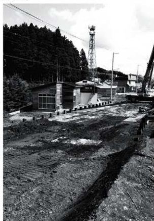
H鋼打設作業終了状況（南→）
