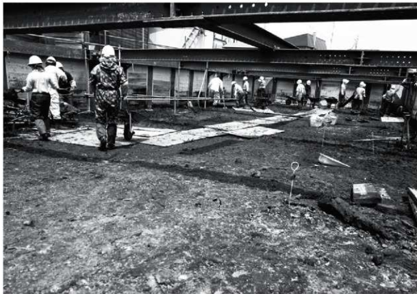
排水用側溝掘削作業状況（南→）
