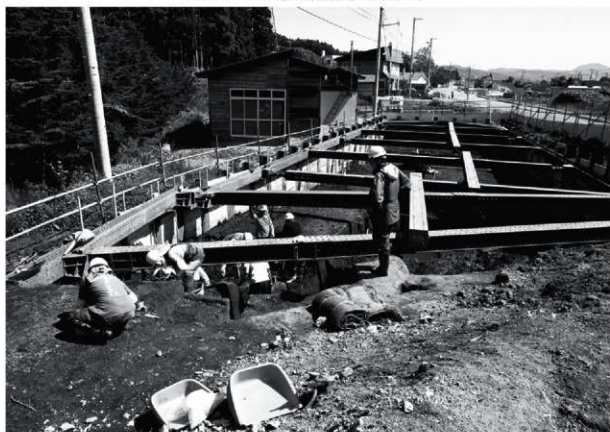
ベルトコンベア下部分調査状況（南→）
