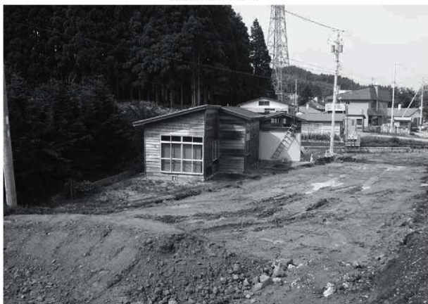
矢板撤去後埋戻し状況（南→）
