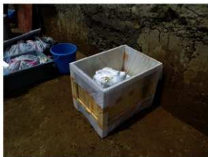
4 木枠設置(ウレタン注入前)
