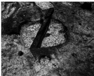
2. H-5 調査状況
