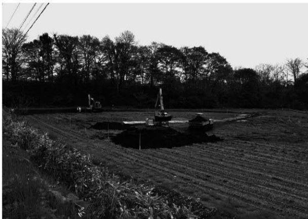
2 表土除去作業
