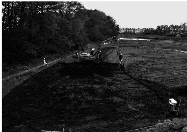
1 表土除去作業
