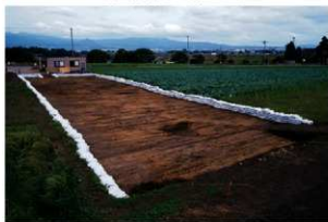
F地区完掘（西から）
