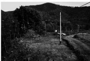
2 表土除去後 (南から)
