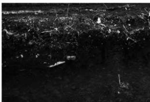
4 町道下部断面 (西から)
